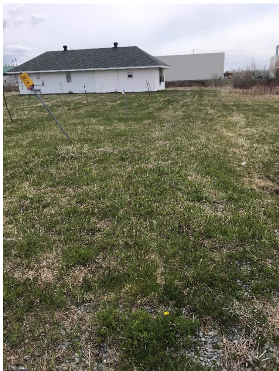
Figure 4: Vue bâtiment GCC et câbles enfouis
