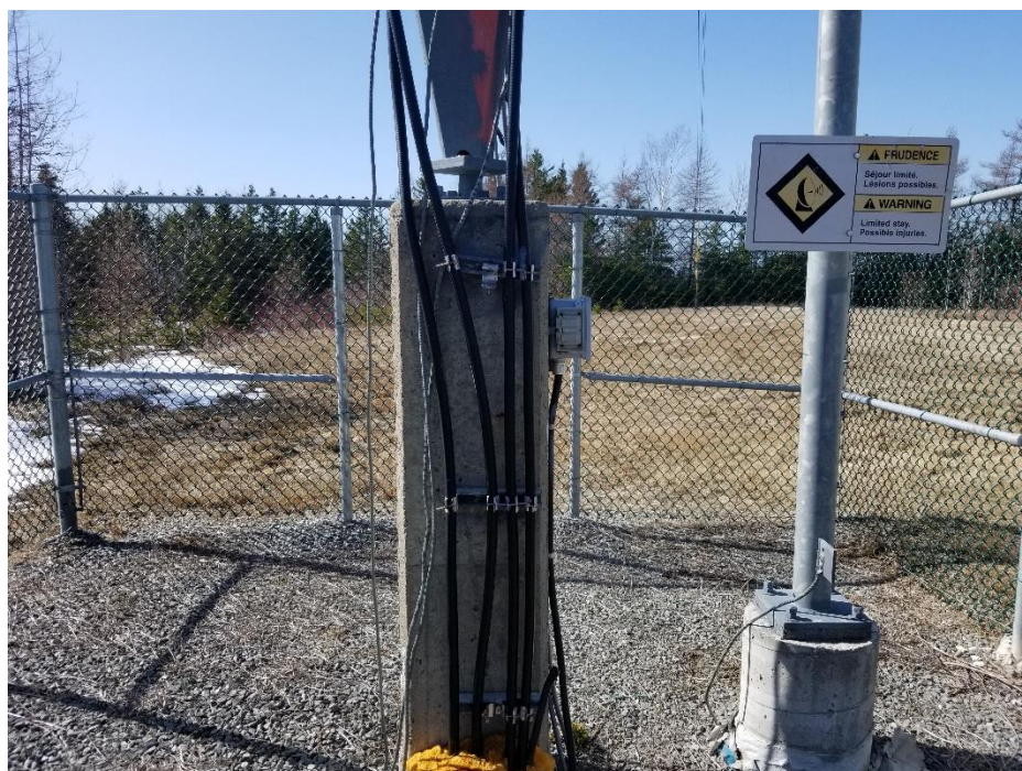
Figure 2: Câbles à dégager au bas du pylône
