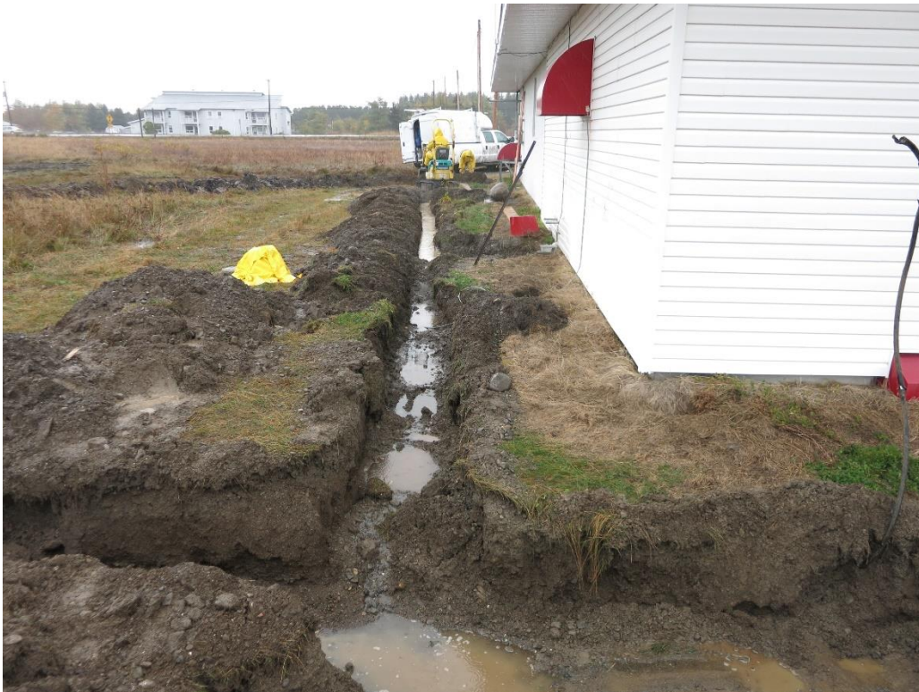
Figure 7: Tranchée des MALT existants
