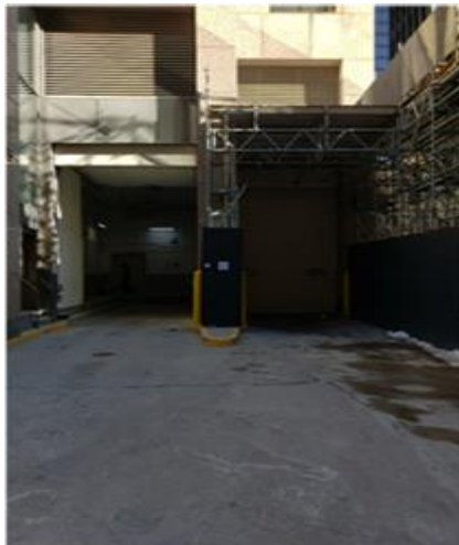
Photo 2 : Quai de chargement 121 avec porte ouverte
