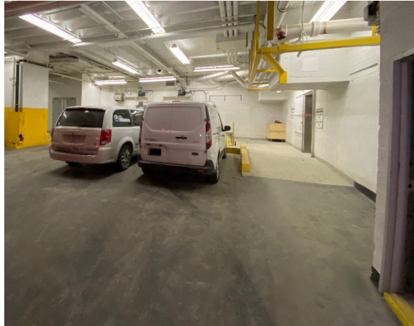
Photo 2: Photo prise depuis la porte du quai de chargement avec vue sur l'intérieur de la zone du quai de chargement
