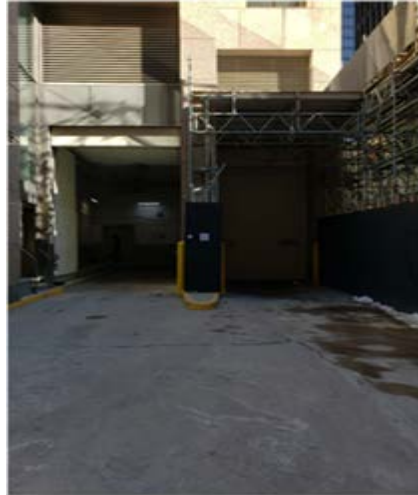
Photo 2 : Quai de chargement 121 avec porte ouverte
