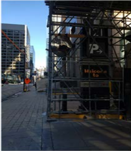
Photo 1 : Photo de côté de la rue au 121, rue King Ouest où se trouve le quai de chargement
