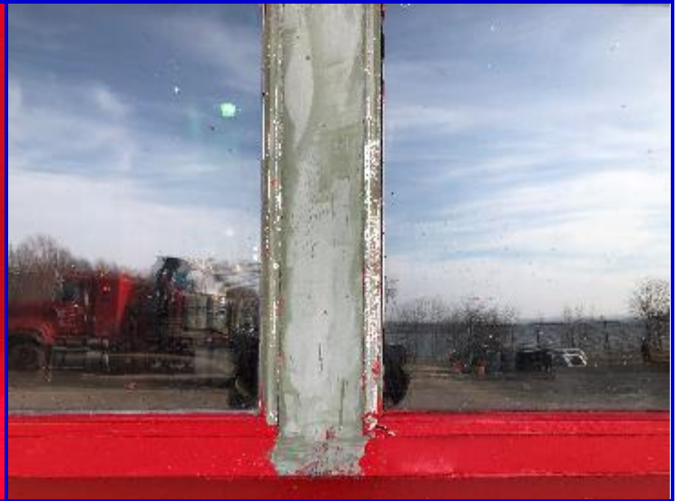
5.12 Door 161B test area
