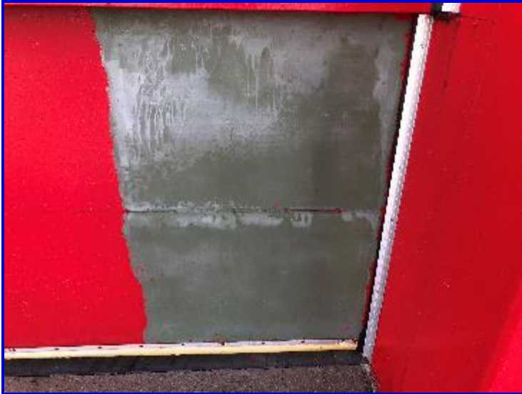
5.11 0.5 m2 test area door 161B
